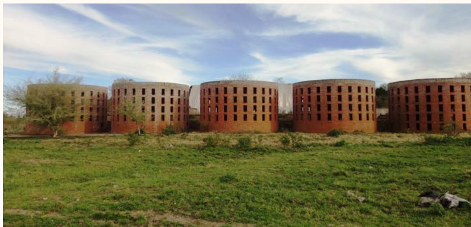
Imagen 2. La falta de inventario y valoración compromete la pérdida de la obra de Dieste a lo largo y ancho del territorio uruguayo. Malas intervenciones y demoliciones comienzan a ser la práctica común. Bases en ladrillo para silos graneleros metálicos. Complejo de Rausa, Montes, Canelones. Foto: Ciro Caraballo, mayo 2014.
