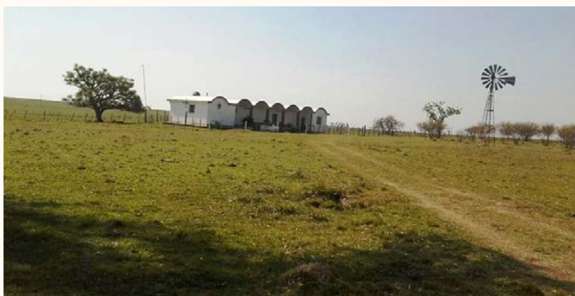
Imagen 4. El sistema constructivo de pequeñas bóvedas portantes, ensayado por Dieste en su casa de Punta Gorda en 1961, fue la base para la autoconstrucción de 285 escuelas rurales como parte del «Plan Gallinal». Escuela rural en Artigas. Foto: Gilberto Pilecco. 2015.
